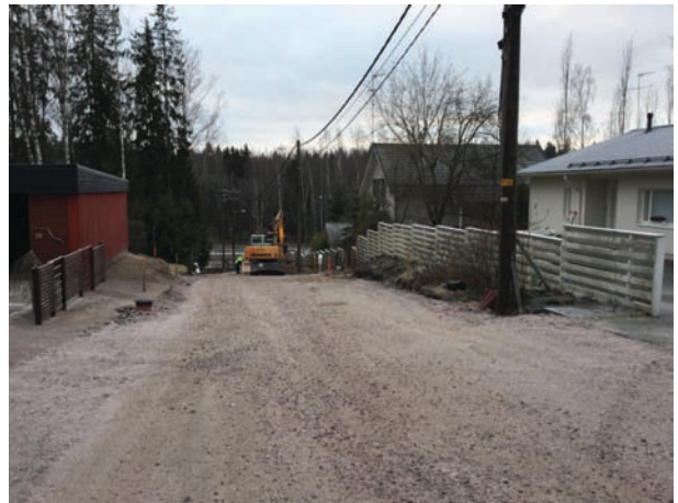
Fig. 2. Street renovation site (Tammitie, Espoo).
